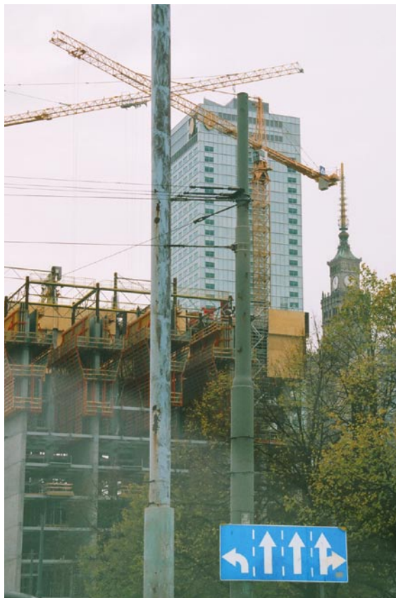
Centrum to wielki plac budowy
